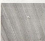
DETALHE das novas telhas, com furos
