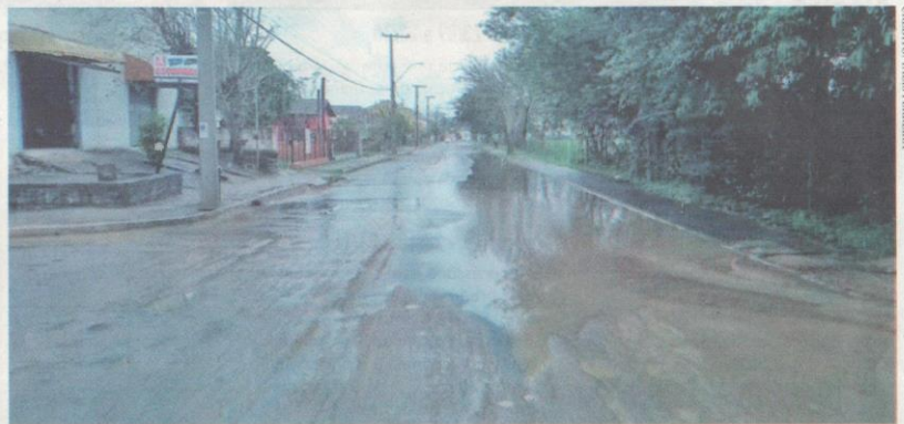
COM as últimas chuvas, a rua voltou a ficar alagada. Com a água, o barro do bueiro subiu, deixando a via suja e intransitável
